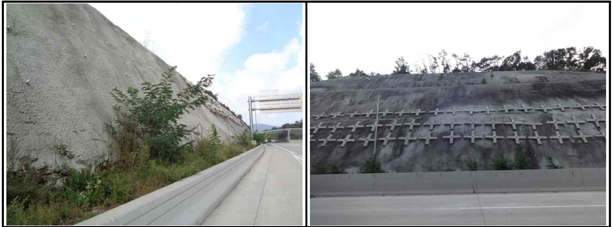
【그림 23.3.4】 보호/보강시설 전경
