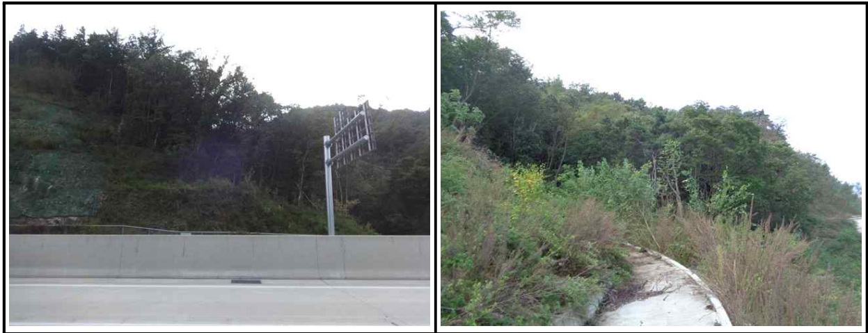
【그림 23.3.1】 상부자연사면 전경
