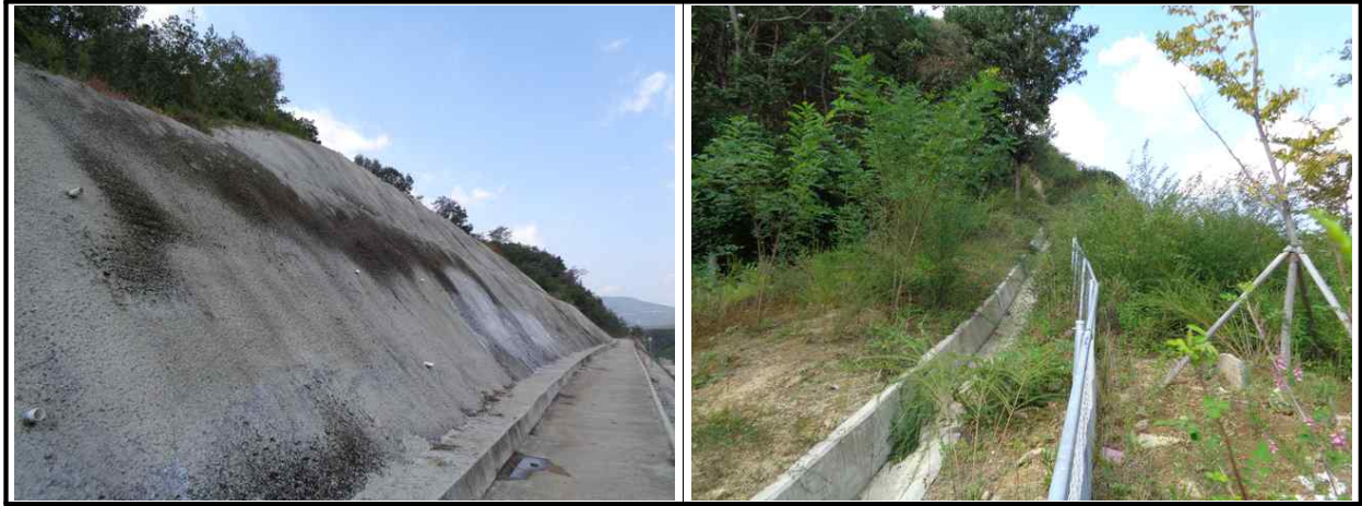
【그림 23.3.3】 배수시설 전경
